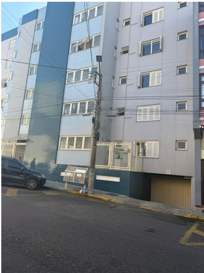
Foto 3: Vista frontal esquerda Fonte: Carvalho Lira Engenharia, 2026
