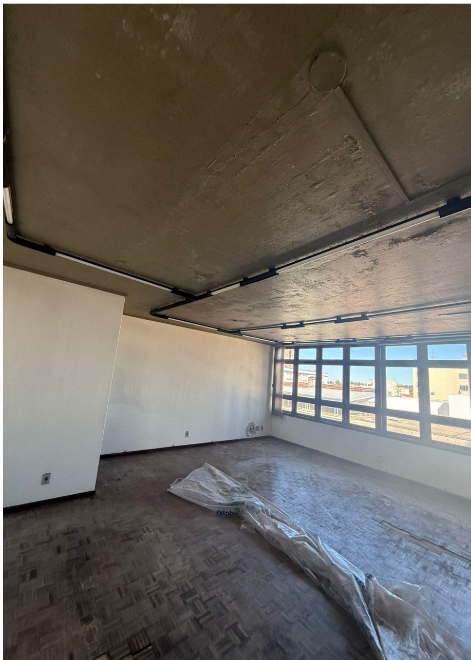
Foto 10: Sala 41 interna Fonte: Carvalho Lira Engenharia, 2026
